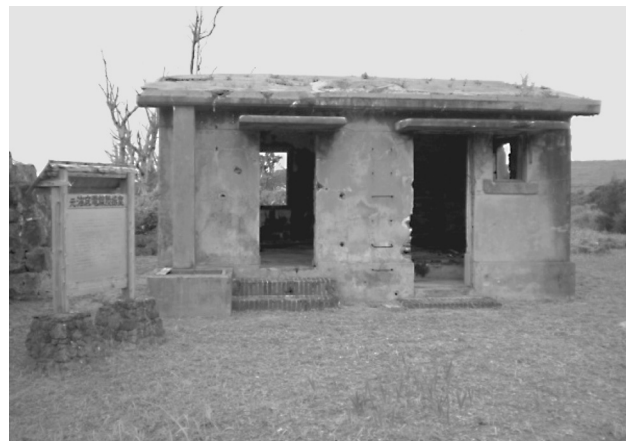
石垣市崎枝に現存する陸揚げ施設跡 (撮影：島田 2010年3月)
