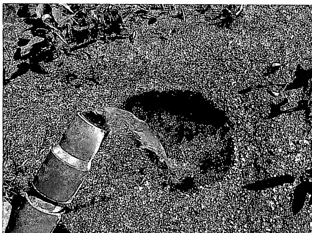
温泉の引き込み口
