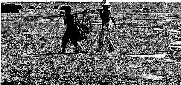
写真2 オーダ(モッコ)を使った石の運搬
