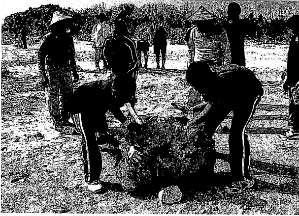
写真1 テコを使った石の運搬
