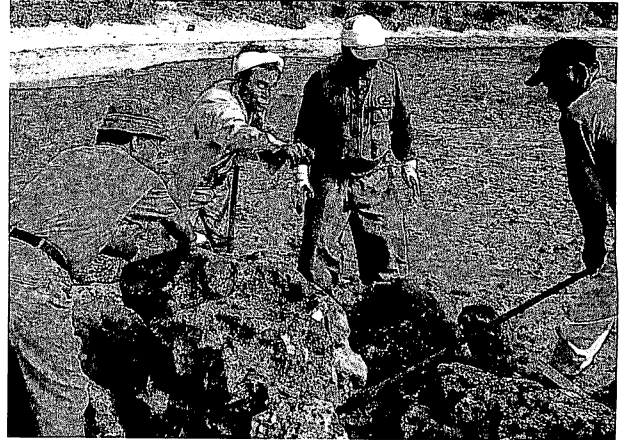
写真3 ティンガラを用いて石を動かす作業風景
